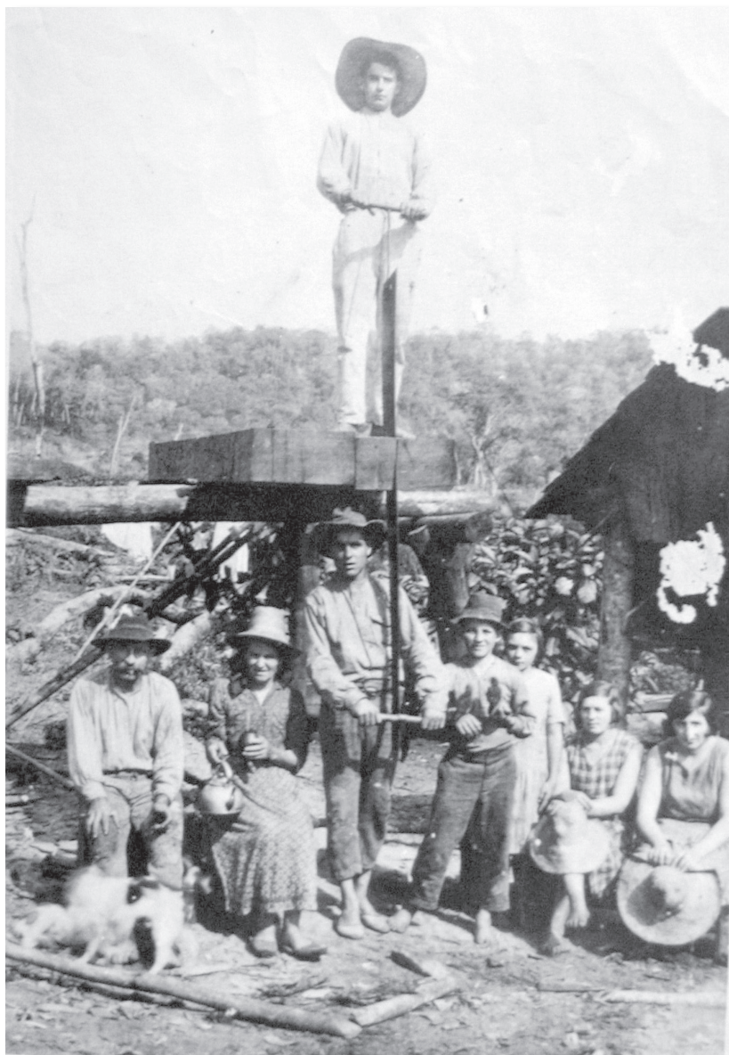
Figura 8 – Estaleiro para corte de tábuas e barrotes Fonte: Palmitos ([19--c]).
