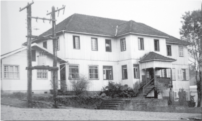
Figura 18 – Hospital da Comunidade Evangélica de Palmitos Fonte: Palmitos ([19--g]).
