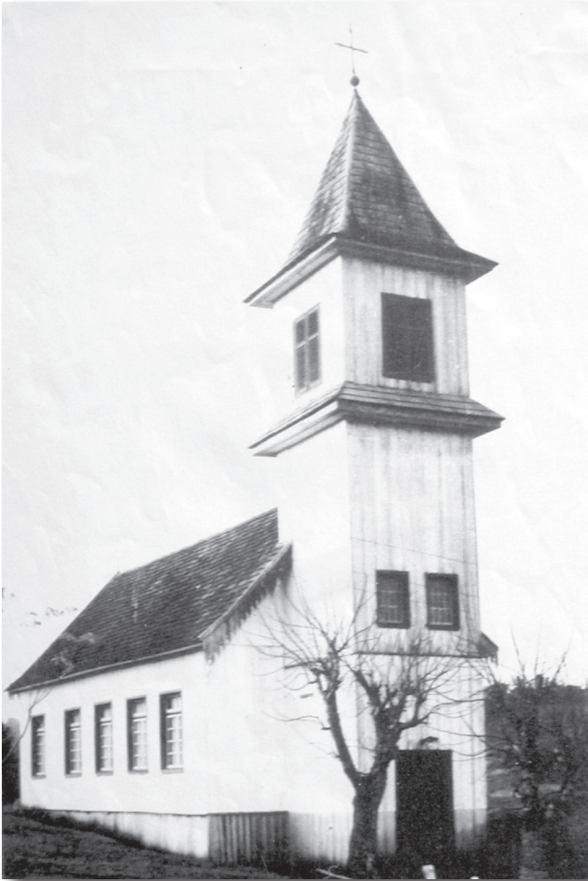
Figura 13 – Igreja Evangélica de Palmitos (construção em madeira) Fonte: Palmitos ([19-f]).
