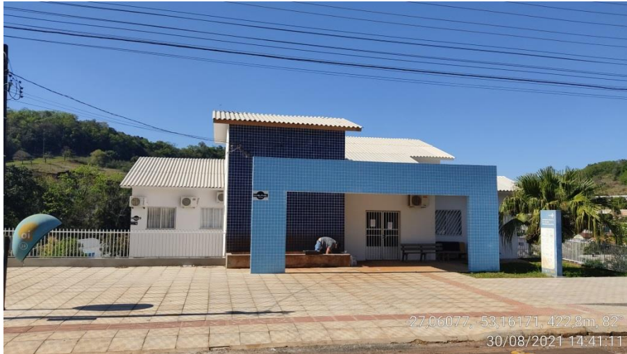
Fotografia 01: Vista da fachada da edificação (UBS Irmando Schappo)
