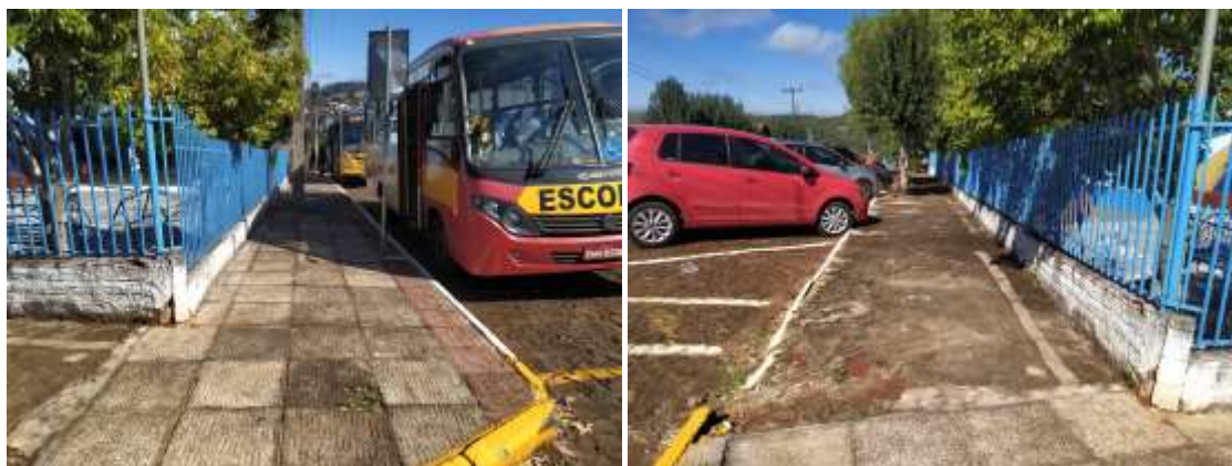
Imagens da calçada existente – deverá ser removida.
