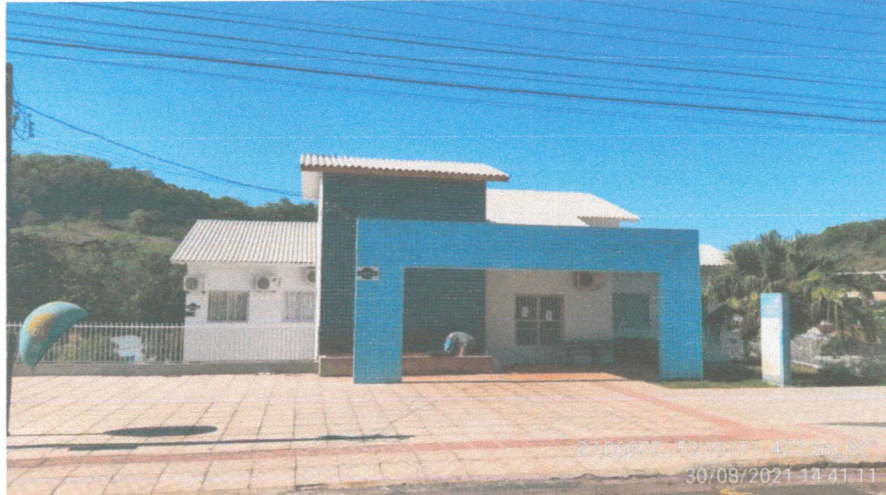
Fotografia 01: Vista da fachada da edificação (UBS Irmando Schappo)
