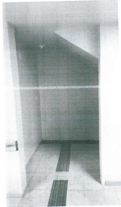
Fotografia 04: Vista interna. Local da porta de acesso do pavimento inferior (subsolo).
