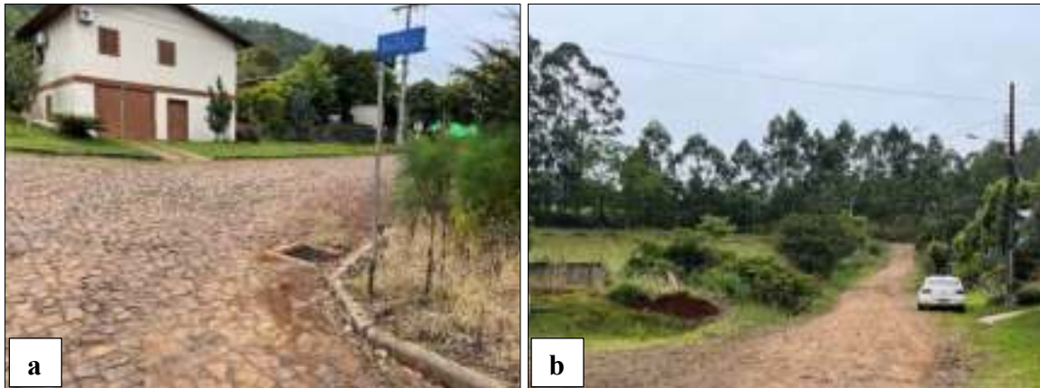
Figura 95 –Via urbana com pavimentação em (a) paralelepípedo e (b) estrada de terra.
