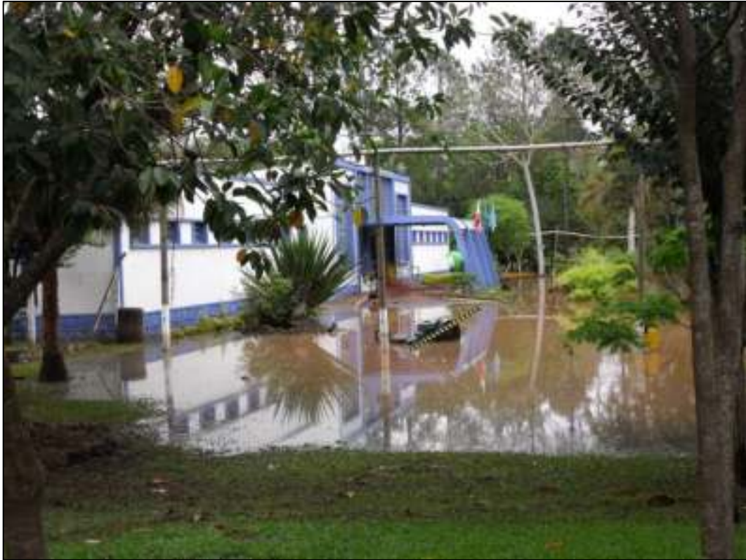
Figura 130 – Evento de inundação ocorrido em 2014 no Distrito de Ilha Redonda.
