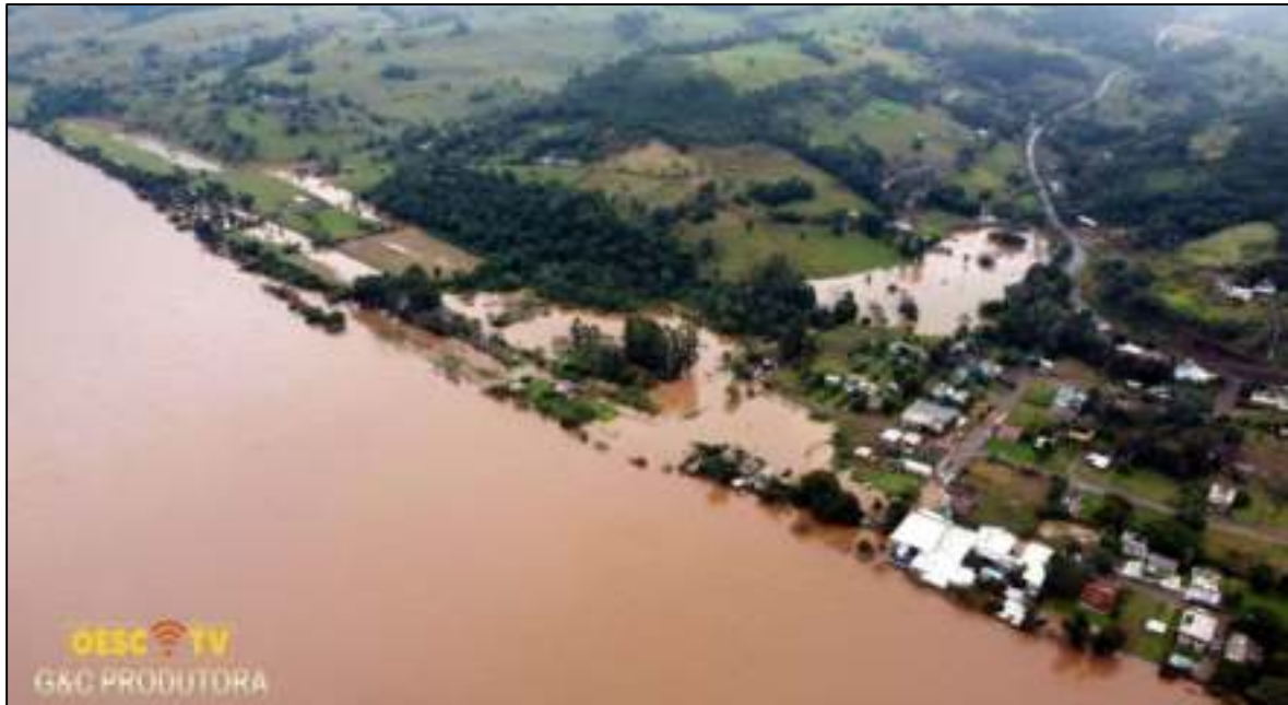
Figura 132 – Evento de inundação ocorrido em 2022 no Distrito de Ilha Redonda.
