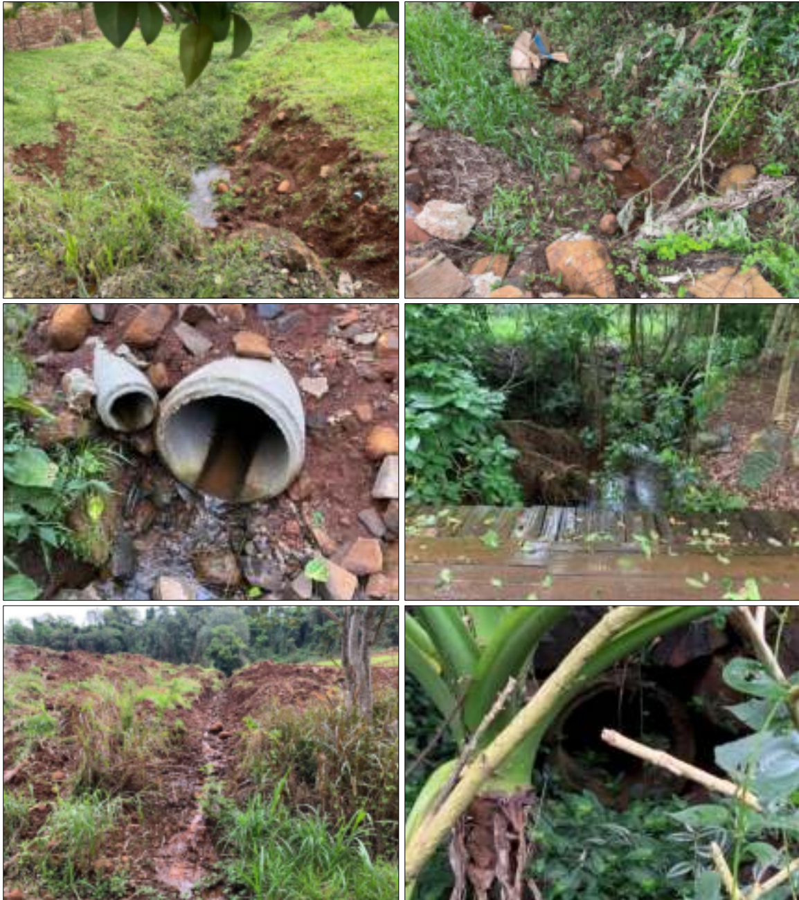
Figura 71 - Exemplo de imagens obtidas em campo para verificação dos recursos hídricos existentes.
